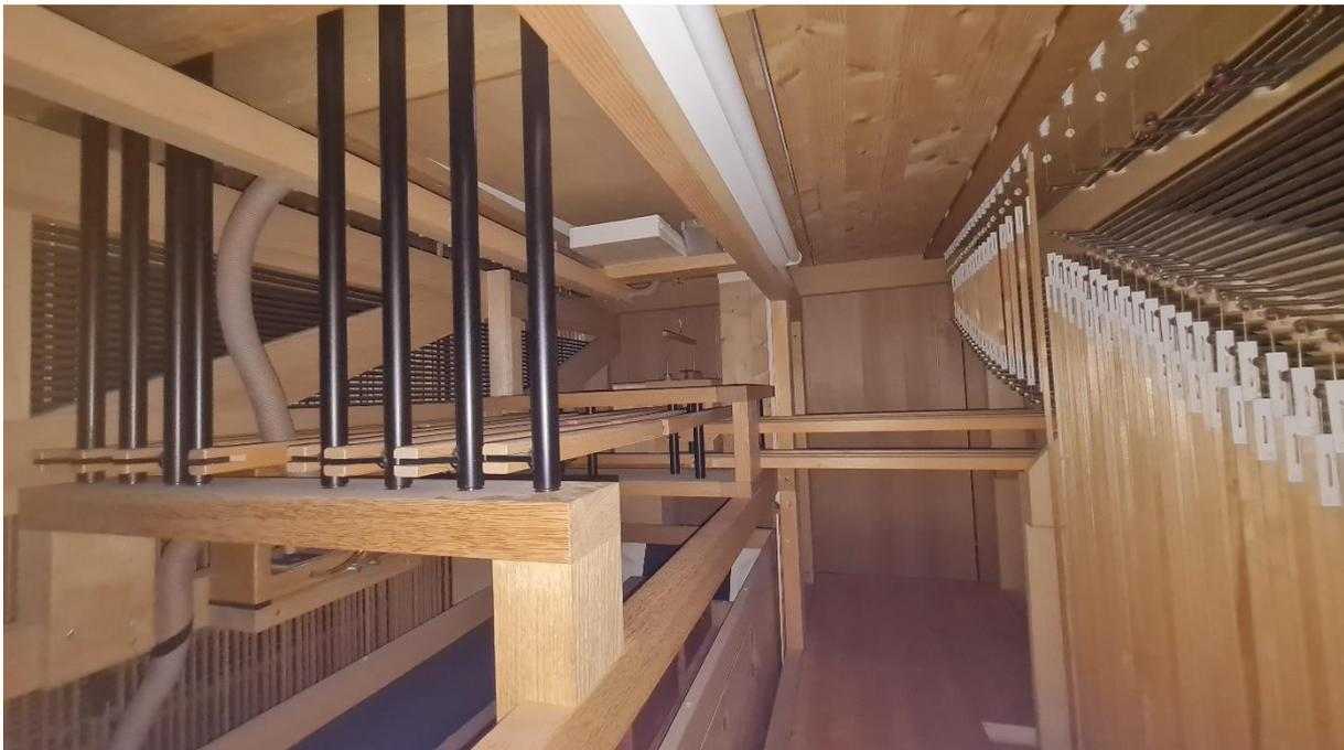
*Abbildung 8: Technik unter dem Schwellwerk*
