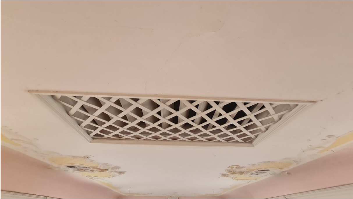
Abbildung 3: Schallöffnung über der Empore
